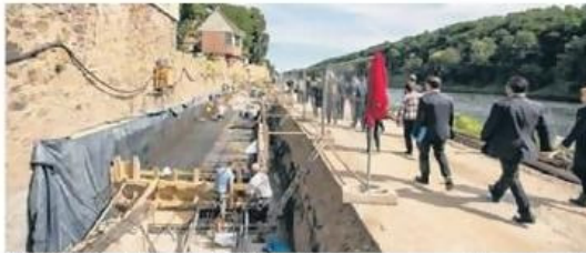
Flutschutz-Baustelle an der Mulde in Grimma.
