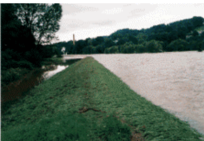
Hochwasser 2002 an der Flöha bei Flöha, Landkreis Mittelsachsen: Deichüberflutung (Foto 13.8.2002)
