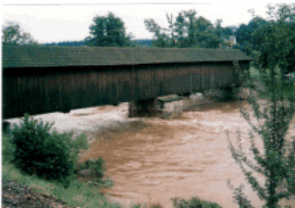
Hochwasser 2002 an der Flöha bei Hohenfichte, Landkreis Mittelsachsen: die vor 180 Jahren erbaute Holzbrücke hielt nicht nur dem Hochwasser stand, sondern verursachte auch keinen Aufstau. (Foto 13.8.2002)
